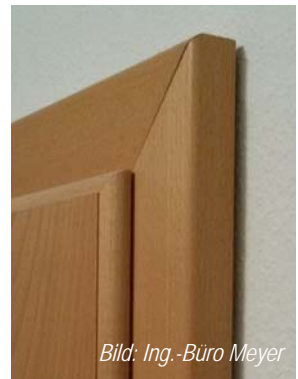
Abb. 14 Diese offene Fuge zwischen Zarge und Wand (< 7 mm) ist nach allgemeiner Auffassung zu tolerieren. Die Zarge wurde lotrecht montiert, die Wand entspricht den Vorgaben der DIN 18202.
