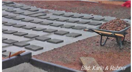
Abb. 9 Die Betonplatten dienen zur Lastverteilung auf den Unterbau. Setzungen werden so reduziert.
