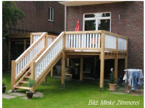
Abb. 10 Aufgeständerte Terrassen bieten Flächenerweiterungen auf ganz einfache Art. Aufwendige Erdanfüllungen können vermieden werden.
