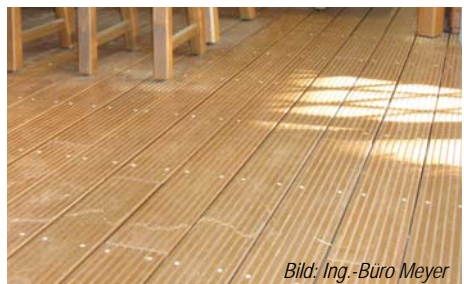
Abb. 17 Sichtbare Verschraubung der Dielen.
