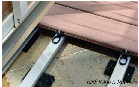
Abb. 8 Ist eine geringe Aufbauhöhe notwendig, kann eine Alu-Unterkonstruktion verwendet werden.
