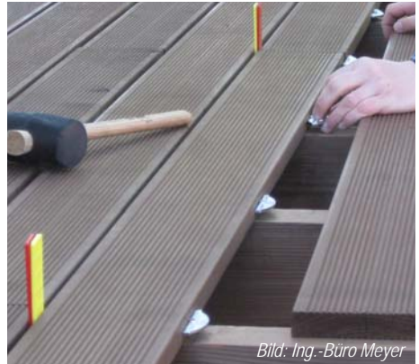
Abb. 18 Unsichtbare Befestigung der Dielen in den Fugen.
