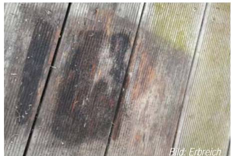
Abb. 20 „Abdruck“ eines Blumenkübels der direkt auf den Dielen stand. Hier verbleibt eine erhöhte Holzfeuchte mit der Gefahr von Fäulnis.
