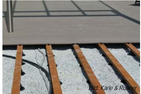
Abb. 14 Unterkonstruktion auf Kiesbett.
