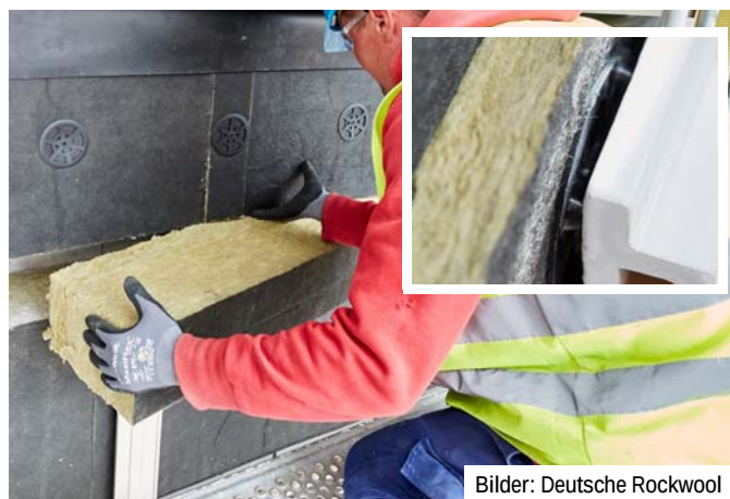
Abb. C11.17 Brandsperre aus Steinwolle-Dämmplatten. In diesem System wird mit Abstandhaltern der Hinterlüftungsraum im Bereich des Brandriegels auf 9 mm reduziert (kleines Foto).
