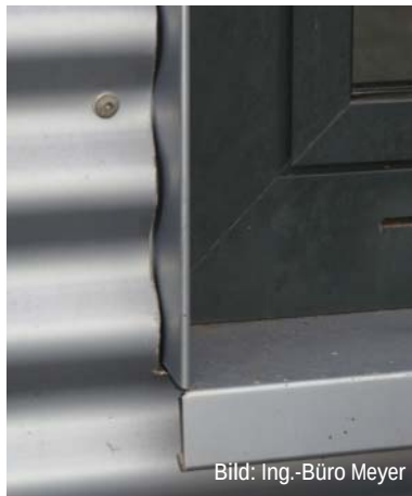
Abb. D16.5 Als Systemzubehör sind Kanteile verfügbar, z. B. Sturz- und Leibungsprofile.
