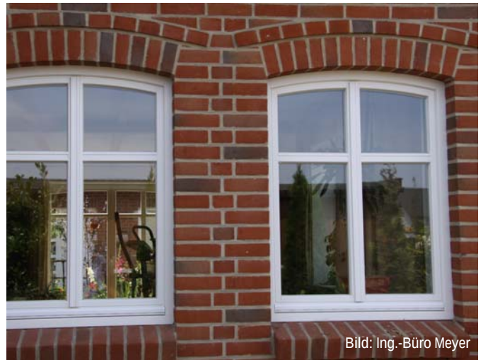
Ziermauerwerk am Fenstersturz. Rollschicht als Fensterbank. Unterhalb der Rollschicht ist eine wasserführende Schicht mit Anschluß zum Fensterbankfalz erforderlich.
