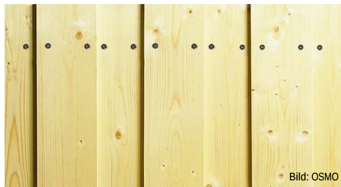
Abb. D12.8 Für eine optisch zufriedenstellende Ausführung dürfen die Befestigungsmittel (Nägel oder Schrauben) von einer gedachten Mittellinie (Länge 2 m) um nicht mehr als \pm 0,5 cm abweichen. Zwei benachbarte Befestigungsmittel dürfen um max. 0,5 cm versetzen.
