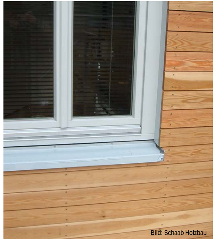
Hier ist die Befestigung sichtbar. Bei Breiten mit mehr als 80 mm mit zwei Befestigern. Bei dem seitlichen Anschluss der Fensterbank ist Verbesserung notwendig (Siehe „Übergänge von der Fassade zum Fenster“ auf Seite 131). Offene Brettenden sollten möglichst vermieden werden.
