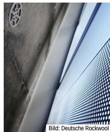
Abb. C13.23 Der Blick in die Luftschicht dieser besonders transparenten Fassadenbekleidung zeigt die besondere Bedeutung der UV-Beständigkeit und die schlagregensichernde Wirkung der Fassadenbahn.
