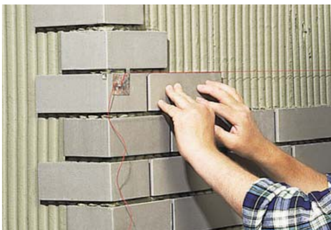
Das Verlegen der Riemchen auf der Putzträgerplatte erfolgt im „Float- und Buttering-Verfahren“ (siehe auch Seite 163).
