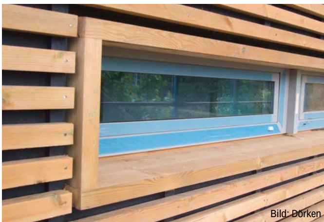
Lückenschalung mit sichtbarer Befestigung und breiten Fugen. Die Fassadenbahn muss für den hohen Fugenanteil dauerhaft UV-beständig sein und den Feuchteschutz allein gewährleisten. Die Bekleidung einschl. Unterkonstruktion ist in die Gebrauchsklasse GK 3.1/3.2 einzuordnen.
