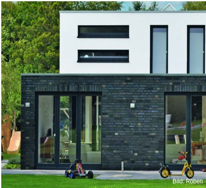
Verblendfassade aus dunklem Hartbrandklinker.
