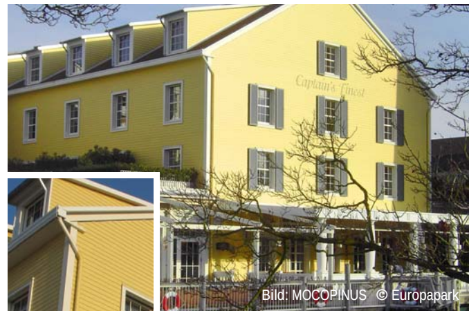
Abb. C11.19 Mit Hilfe einer Kesseldruckimprägnierung auf Basis von Phosphorverbindungen wurde bei dieser Fassadenbekleidung eines Hotelgebäudes der Gebäudeklasse 4 die Euroklasse B-s2, d0 erreicht.
