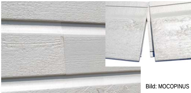
Abb. D12.16 Profilbretter mit stirnseitiger Nut-/Federverbindung ermöglichen eine Endlosverlegung im unregelmäßigen Verband. Das Fassadenbild wirkt flächig, der Verschnitt wird reduziert.
