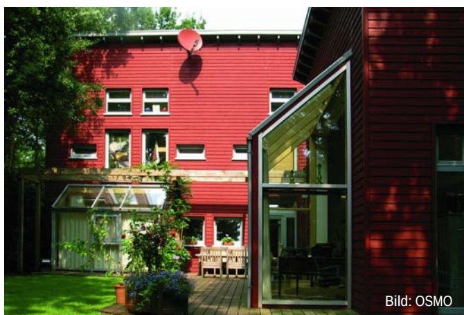
Abb. D11.17 Die Beschichtung einer Holzfassade kann in Teilbereichen unterschiedlichen klimatischen Einflüssen ausgesetzt sein.
