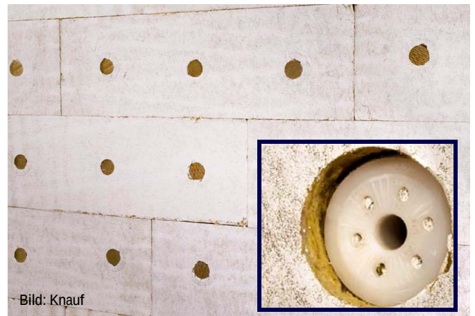
Abb. C12.13 Um Abzeichnungen der Dübel an der späteren Putzoberfläche zu vermeiden, gibt es die Möglichkeit den Dübel zu versenken (kleines Bild).
