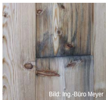
Abb. D12.3 Boden-Leisten-Schalung mit verdeckter Befestigung der Bodenbretter ( > 120 mm) in Längsrichtung im Wechsel versetzt. Der Mindestabstand bei Nägeln beträgt \geq 15 mm, bei Schrauben \geq 20 mm.
