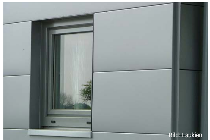
Abb. D16.7 Die Verlegung der Aluminium Steckpaneele erfolgte bei diesem Gebäude ohne Schattenfuge. Für die Fassadenecke wurde ein Außeneckprofil (Kantteil) aus dem Zubehörprogramm gewählt.
