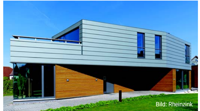
Abb. D16.6 Die Fassade des Obergeschosses wurde bei diesem Objekt mit Horizontalpaneelen aus Titanzink ausgeführt.
