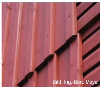
Abb. D12.6 Beispiel einer Boden-Leisten-Schalung am Geschossstoß, ausgeführt als Überlappung. Das untere Brettende wurde mit 15° angeschrägt. Es ist ein Übergang zu einer Horizontalschalung zu erkennen.
