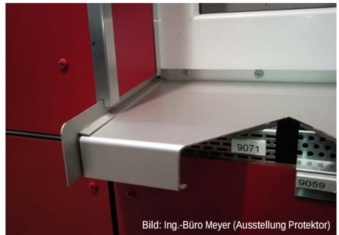
Abb. C13.25 Fassadenbekleidung aus Plattenwerkstoffen auf Aluminiumunterkonstruktion. Anschlussdetail einer Fensterbank mit Fensterleibung.
