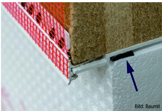
Abb. C12.12 Die Perimeterdämmung schließt mit einem Dichtband zum Sockelprofil ab (komprimiert ca. 4 mm). Damit ist diese Fuge spritzwassergeschützt.
