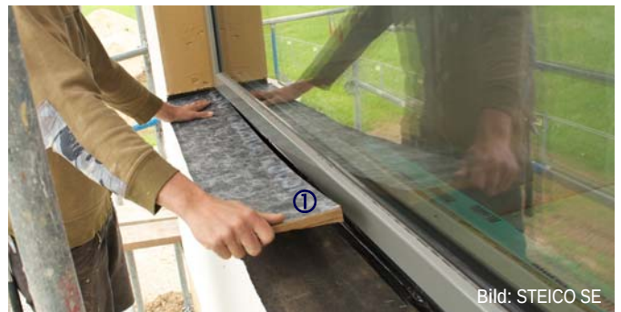
Abb. C14.29 Holzfaser-Dämmkeil mit Kaschierung einer Dichtbahn zur einfachen Herstellung einer zweiten Dichtungsebene unter äußeren Fensterbänken.
