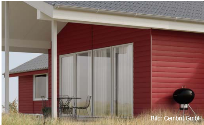
Abb. D17.12 Eine Stülp-schalung aus Faserzement-Sidings greift die klassische Fassadengestaltung auf. Es kann aus zahlreichen Farbtönen ausgewählt werden.
