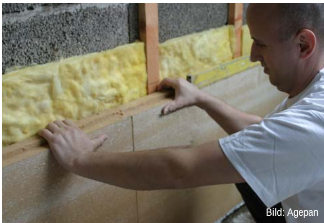
Abb. C12.7 Holzfaserdämmplatten als WDVS auf Grundlatten bei der Altbausanierung. Die Befestigung erfolgt sehr kostengünstig mit Breitrückenklammern (Druckluftnagelgeräte). Diese Bauart hat besondere Vorteile auf schwierigen Untergründen und bei Fassadenkombinationen.
