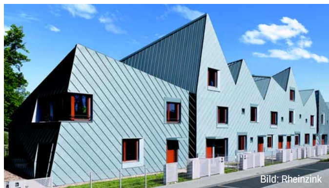
Abb. D16.8 Dach und Fassade wurden bei diesem Objekt mit Winkelstehfalztechnik in Titanzink ausgeführt.
