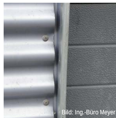
Abb. D16.3 Ausreichender Abstand der horizontal verlegten „Sinuswelle“ zum Torprofil.
