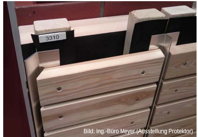
Abb. C13.24 Fassadenbekleidung als Lückenschalung auf Holzunterkonstruktion. Leistenstöße und -ecken mit beliebten „Schwertprofilen“.
