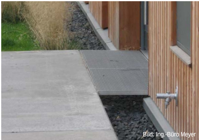
Abb. C11.12 Hier wird der Höhenunterschied mit einer Rampe überwunden und zum Gebäude ein Gitterrost angeordnet. Das Fassadenwasser wird sicher in das Gelände abgeführt.
