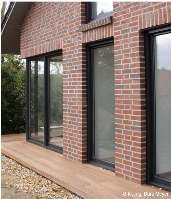
Große Fensterflächen lösen die Verblendfassade auf. Was hier leicht wirkt, ist statisch kompliziert. Das Verblendmauerwerk muss beim Fenstereckelement mit Konsolen abgefangen werden.
