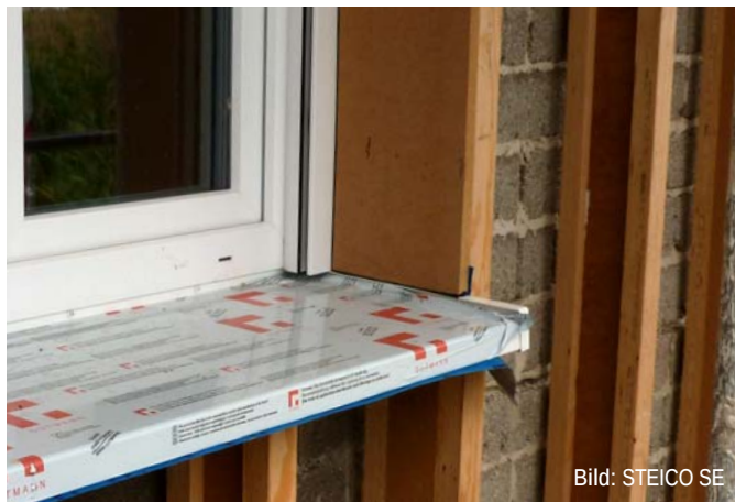
Abb. C14.28 Der Ablauf für den Einbau von Fenster und Fensterbank wird an diesem Beispiel deutlich. Die Fensterbank ist sehr früh montiert, so wird die Fassade an die Fensterbank „herangebaut“. Die zweite Dichtebene unter der Fensterbank ist zu erkennen.
