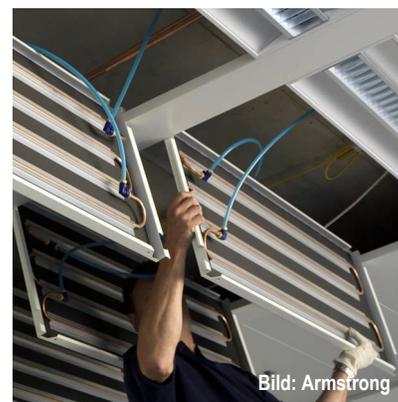
Abb. A4.25 Metallkassetten (aufgeklappt), ermöglichen den Zugang zur Kühldecke.
