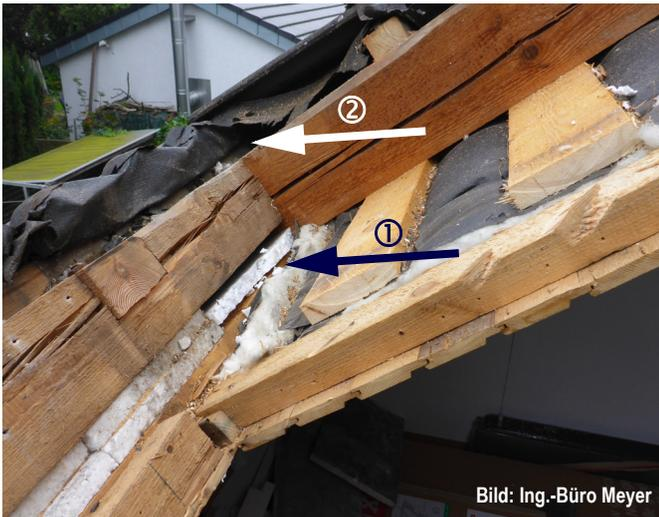
Abb. B5.7 Die vorhandene Dämmebene des Daches ① sitzt deutlich tiefer als das spätere Dachfenster ②. Der Dämmrahmen ermöglicht einen sauberen Übergang der beiden Dämmebenen (Bild unten).
