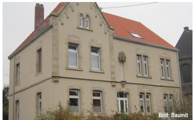
Abb. B3.9 Wie hoch ist die Wasseraufnahme einer Putzfassade? Es sind gute Kenntnisse über die Materialien erforderlich. Risse spielen bei der Beurteilung eine große Rolle.
