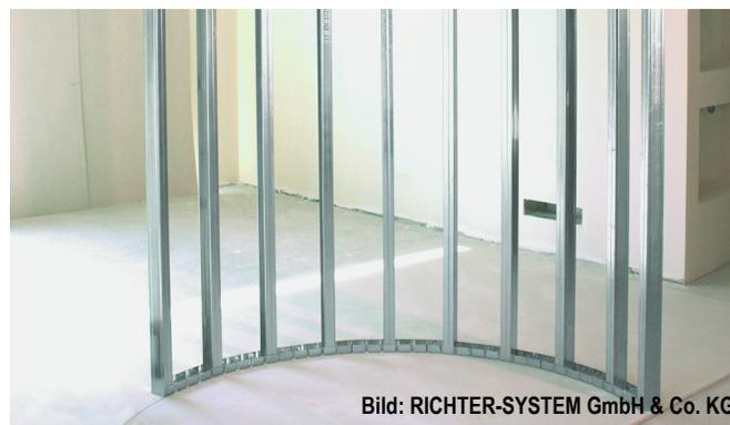
Abb. A2.15 Flexible Profile erleichtern die Erstellung runder Wände. Das U-förmige Randprofil lässt sich biegen, je nach Profilbreite beträgt der kleinste Radius 125 bis 250 mm. Das Profil wird am Boden und an der Decke befestigt. Die Ständerprofile werden anschließend eingestellt.
