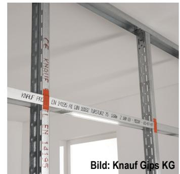
Abb. A5.9 Türöffnung in Metallständerwerk mit seitlichen UA-Profilen und Türsturzprofil.
