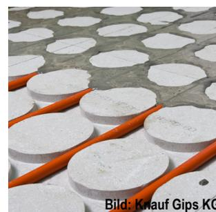
**Bauart A:** Die Heizrohre liegen innerhalb der Gipsfaser-Systemelemente mit Leitungsfräsungen z. B. als Rillen- oder Noppenplatten. Die Platten werden nach Verlegung der Heizleitungen gespachtelt oder vergossen. Durch die Lage der Heizrohre direkt unter dem Bodenbelag ist eine schnelle Wärmeabgabe möglich.
