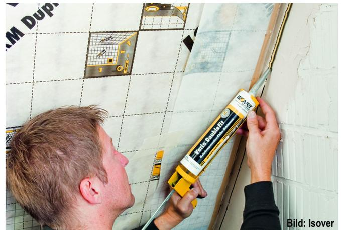
Abb. C2.13 Die Dampfbremse auf der Raumseite des Daches wird z. B. mit einem speziellen Kartuschenklebstoff dauerhaft angeschlossen. Eine Dehnschleife ist dabei für die Verformung zu berücksichtigen.
