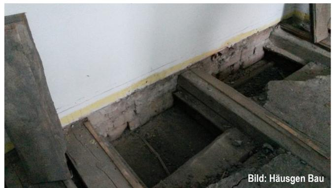
Abb. B3.14 Die Wandaufleger von Holzbalkendecken sollten genauestens geprüft werden. Dies gilt umso mehr für Decken, die von unten bekleidet sind.
