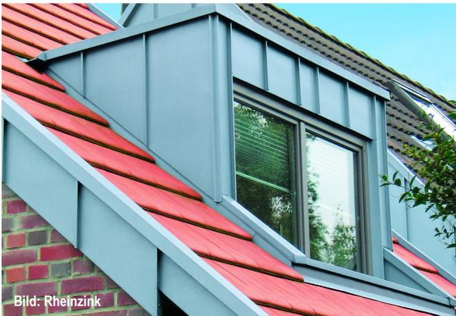
Abb. A1.12 Bei Gauben mit Metalldeckung auf der Außenseite sollte man vor dem Innenausbau genau hinschauen. Das anfallende Kondensat trocknet zur Raumseite ab.
