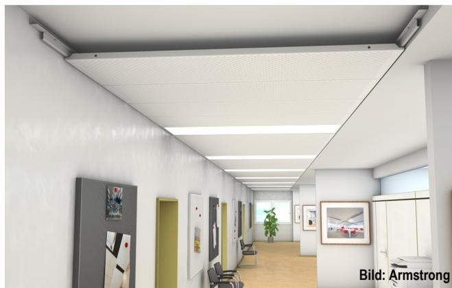
Abb. A4.28 Flurdecke mit selbsttragenden abnehmbaren Metall-Deckenplatten, an Z-förmige-Tragprofile gehängt, mit Wandwinkeln.
