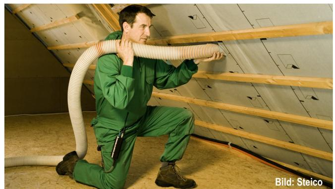
Abb. A1.2 Nur geschultes Personal darf für das Verfahren „Einblasdämmstoff“ eingesetzt werden. Eine besondere auf den Dämmstoff abgestimmte Maschinenteknik ist notwendig.
