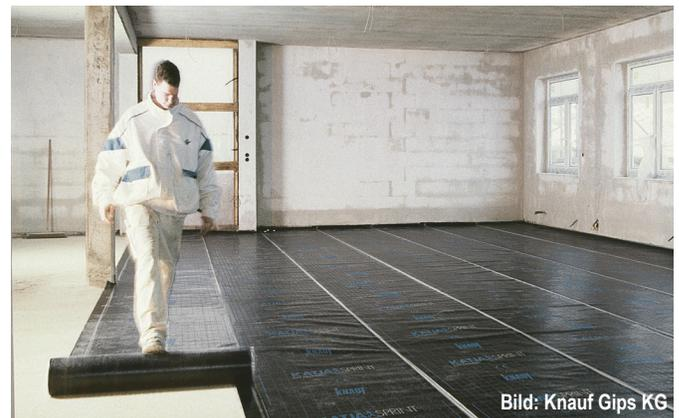
Abb. C1.14 Nachträgliche Abdichtung der untersten Bodenplatte mit einer Polymerbitumenbahn.
