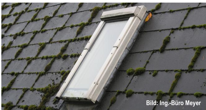
Abb. B5.2 Die Witterung hinterlässt ihre Spuren. Das Material hat eine begrenzte Dauerhaftigkeit.
