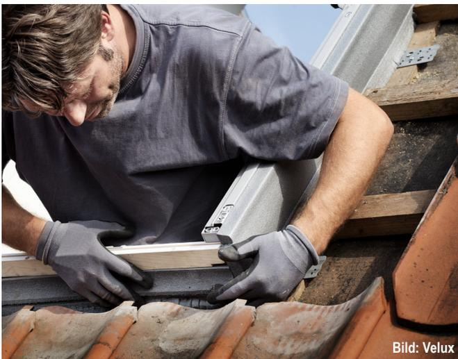
Abb. B5.8 Der **Dämmrahmen(!)** bildet die Basis für das eigentliche Fenster. Er passt sehr genau in die Dachöffnung und wiederum exakt zum Fenster. Wärmebrücken sind dadurch vermieden.
