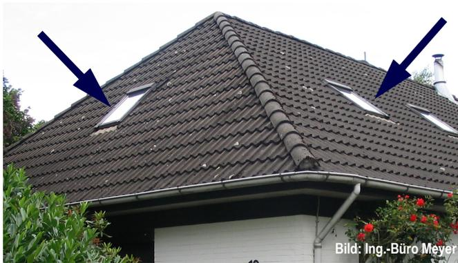
Abb. B5.1 Die früheren Dachfenster waren oft recht klein. Bei einem Austausch sollte eine Vergrößerung in Betracht gezogen werden.
