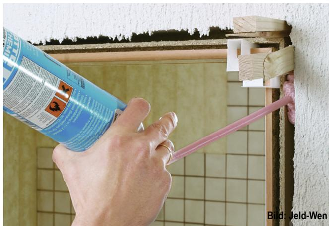
Abb. A5.7 Einbau einer Zarge mit Montageschaum.
