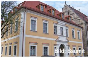
Bild: Baumit     |
