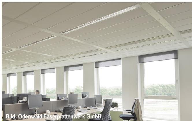
Abb. A4.26 Bandrasterdecken ermöglichen die flexible Abtrennung von Einzelbüros. Leuchten können in das Bandraster integriert werden.
