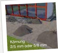
Bei bindigen Böden wie z. B. Lehmböden sollte, nach Prüfung der örtlichen Gegebenheiten, unter Umständen eine Drainage eingebaut werden.
